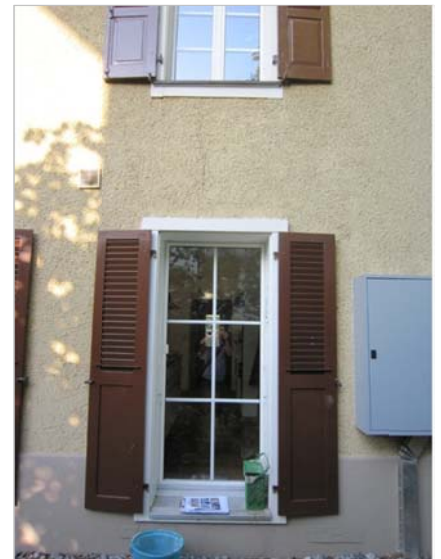
Foto 3 – Sturz bei Küche (Ostfassade)
