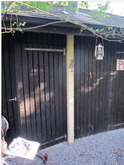
Foto 7 – Riss in Lagerfuge (Velo/Heizung)
